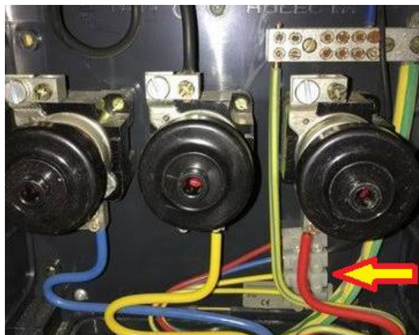
Foto: tariefdraden in de hoofdaansluitkast (HAK)
