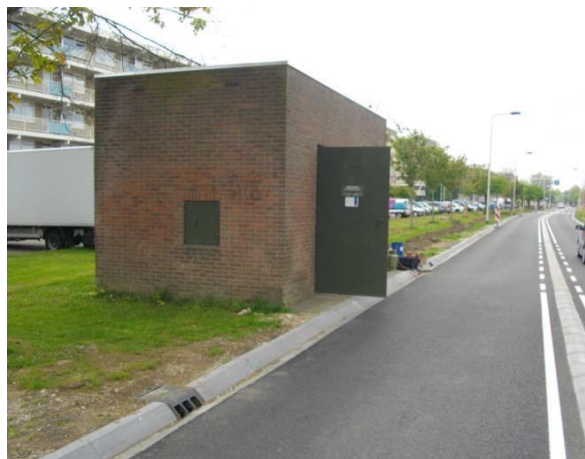
Foto 1: gevaarlijke werkplek door verlegde weg
