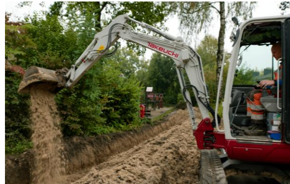
Foto 2: storten van zand in de sleuf zorgt voor extra kracht op kabels en leidingen
