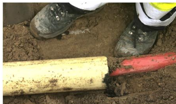
Foto: voorbeeld van gasleiding als mantelbuis
