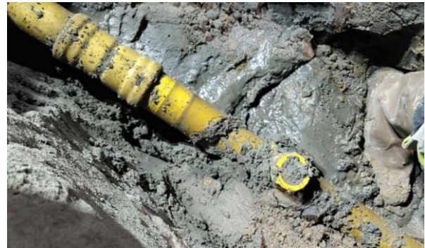
Foto: PVC leiding met niet-trekvlaste verbindingsmof
