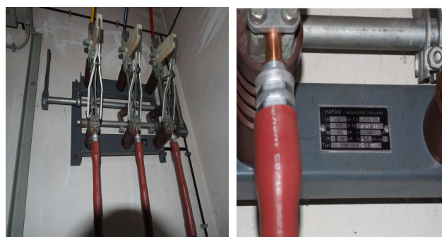
Foto 2 en 3: gemaakte foto's van lastscheider en typeplaatje
