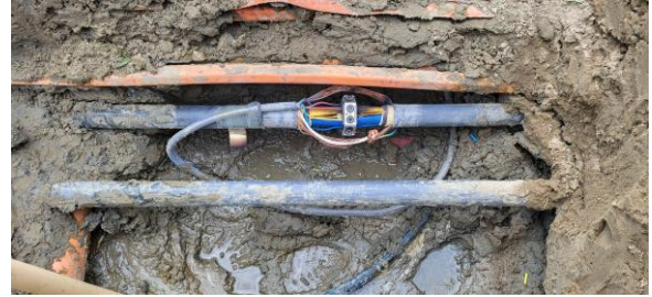
Foto: krappe werkput voor monteren mof
