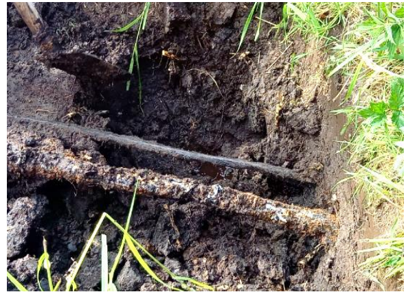
Foto 2: verouderde GPL-kabel in de sleuf (onder)
