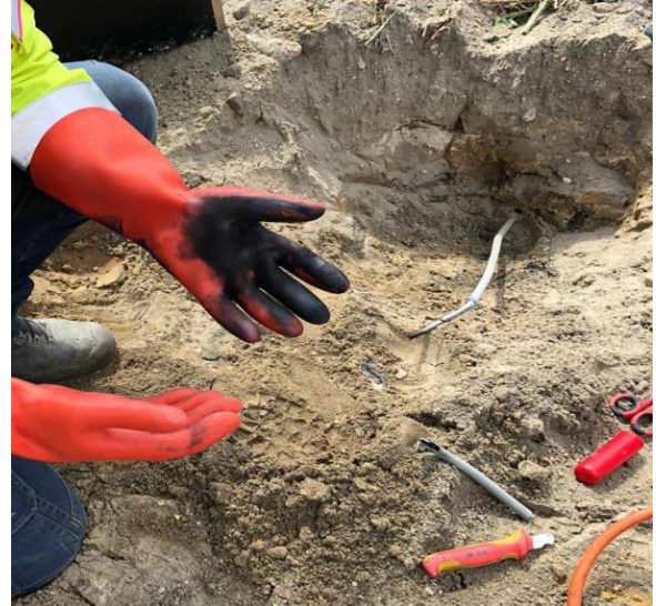
Foto 2: verbrande handschoenen nabij aangepelde kabel
