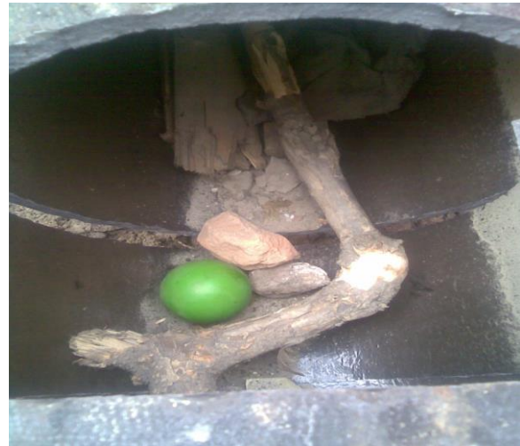
Foto: afval en vuil in gietijzeren buis
