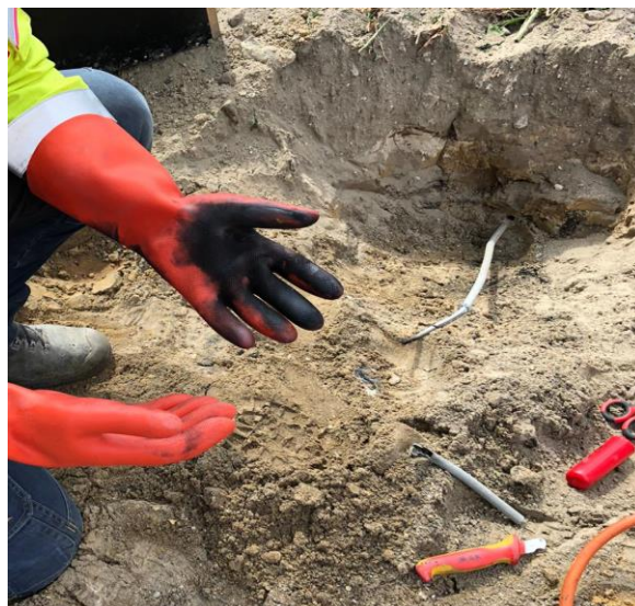
Foto 2: verbrande handschoen nabij aangepelde kabel
